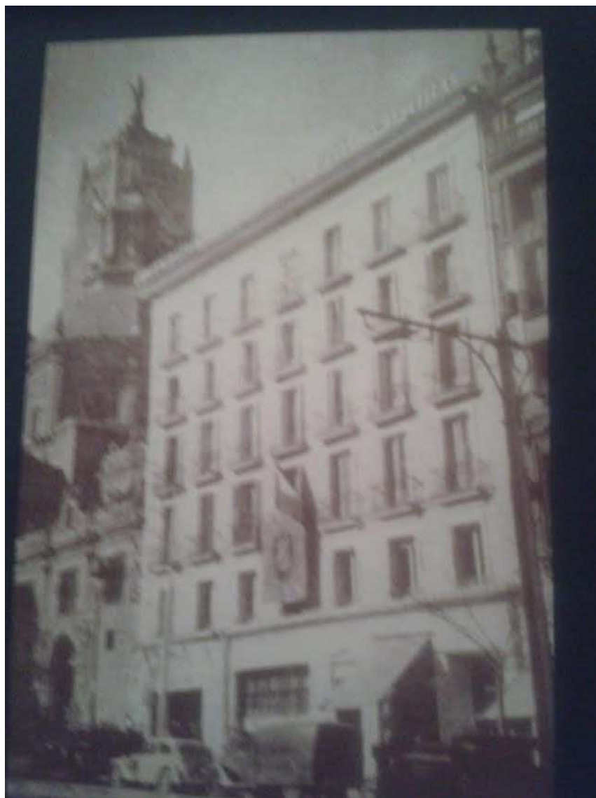
Edificio de la Confederación Española de Cajas de Ahorros, en Madrid.
