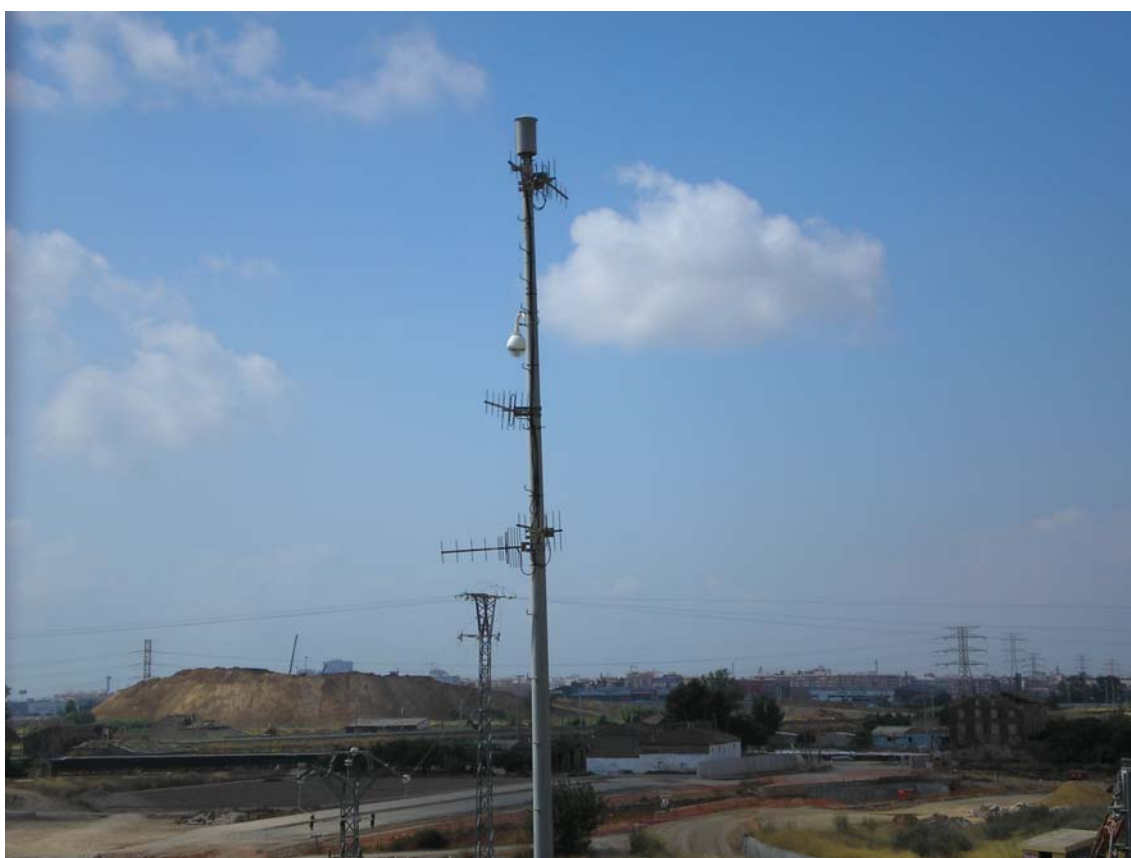
Puesto Fijo en Bifurcación situado en la entrada de la estación Valencia Norte
