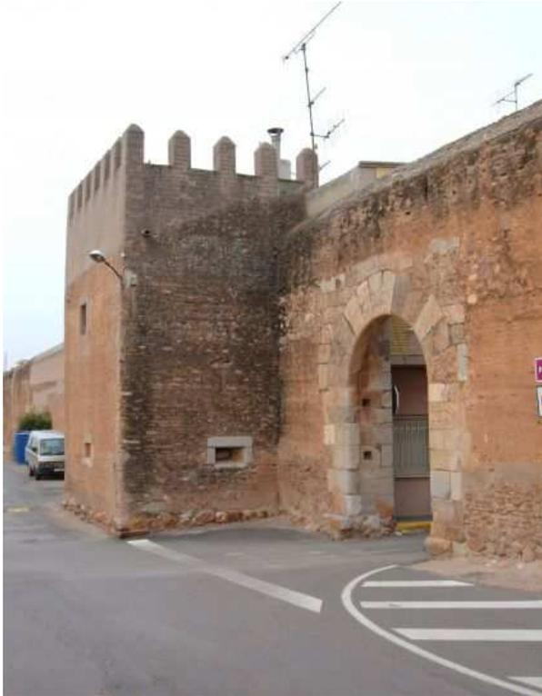
La puerta del este, “Porta de l’Horta” es de sillería y presenta un arco de medio punto de amplio dovelaje que al interior de la muralla se convierte en arco carpanel y muestra los anclajes de las puertas de madera, hoy desaparecidas. En el exterior y a su lado izquierdo, se alza una de las citadas torres defensivas que permite ver la fábrica de mampostería de su cimentación y que presenta dos únicos vanos defensivos, a modo de tronera, rectangular y abocinado.
