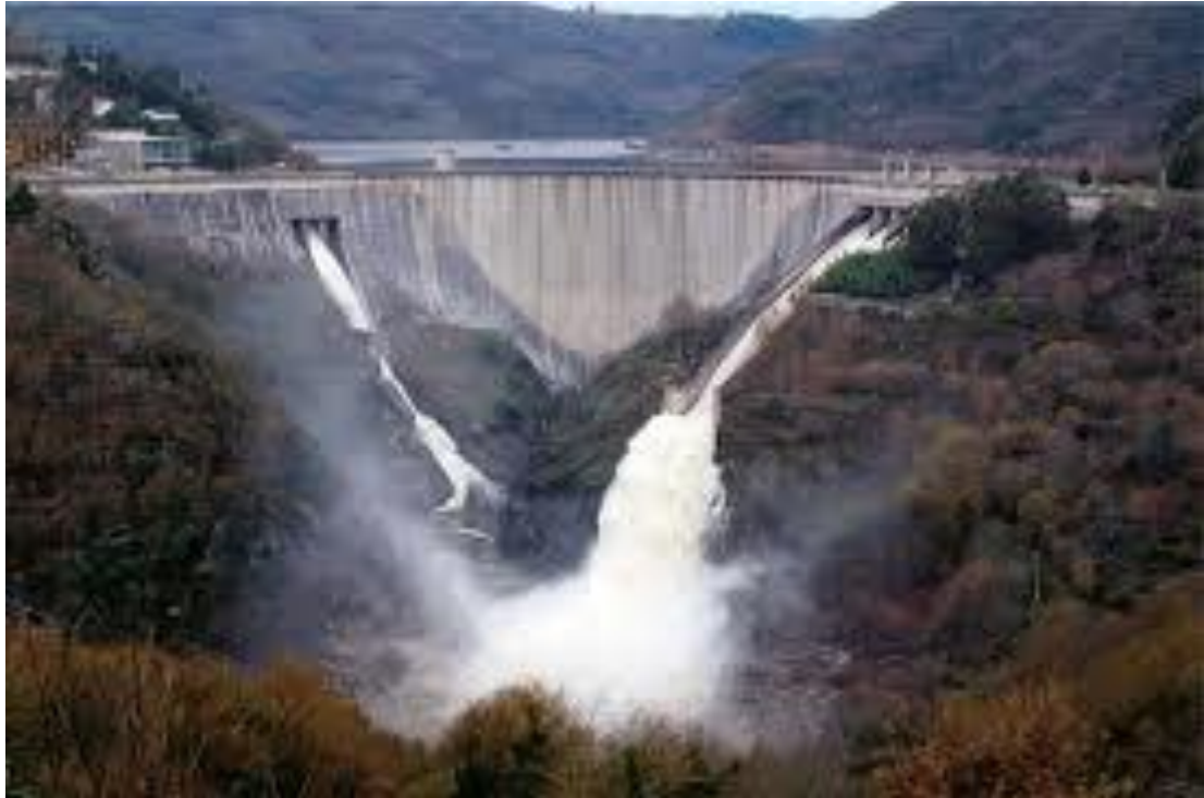
Una presa para producir electricidad.
